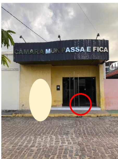
Imagem 01: situação atual fachada/entrada principal.
